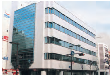
いよぎん三番町ビル落成(平成5年4月2日)
