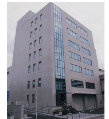
事務センター別館、竣工（平成19年6月7日）
