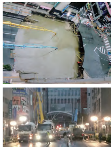
JR 博多駅前の道路陥没事故 (平成 28 年 11 月 8 日)
