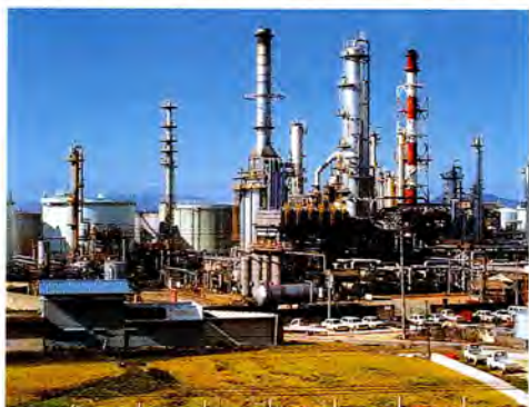
地下備蓄施設のある太陽石油
