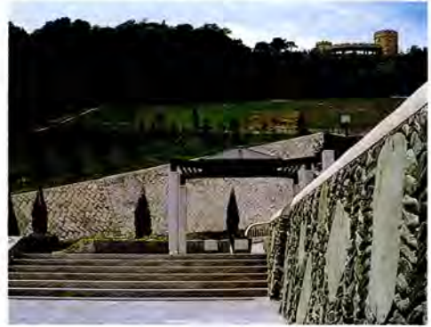
建設進む松山総合公園
