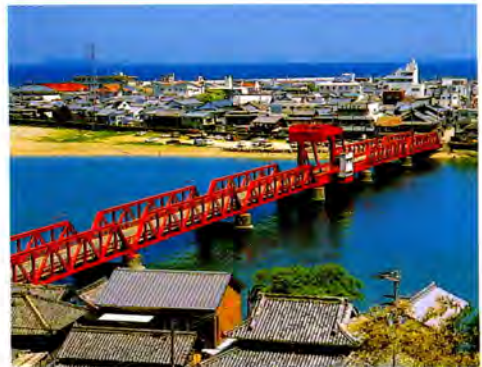
全国唯一のバスキュール式開閉橋「長浜大橋」
