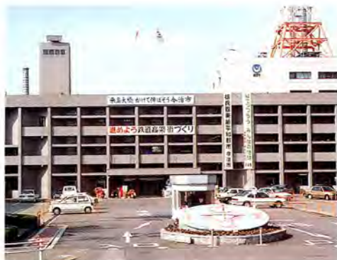
折版構造法建築の今治市庁舎
