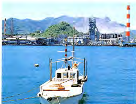
わが国屈指の石灰石鉱山とセメント工場
