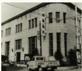
本店の建物は、現在の八幡浜支店で洋館のような佇まいを見せる擬洋風建築
