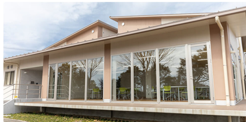
「白浜町第2ⅠTビジネスオフィス」。町の公園管理事務所を建て替え（事業費2.1億円、オフィスは4室）
